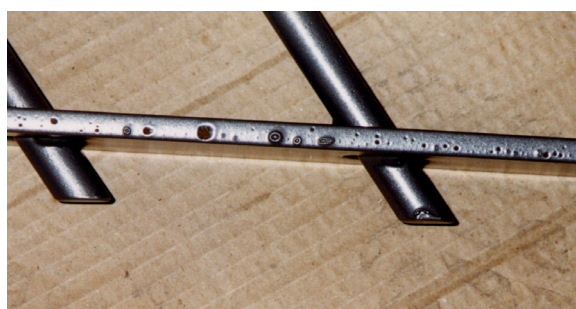
Abb. 3.2.4 Krater im Pulverlackfilm durch Korrosion
