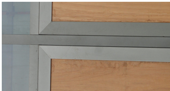
Abb. 7.2.2 Chargenwechsel während der Beschichtung
