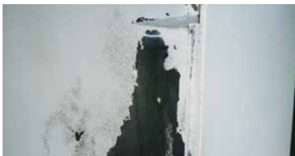
Fig. 2.3.1 Des parties de la couche de poudre glissent
