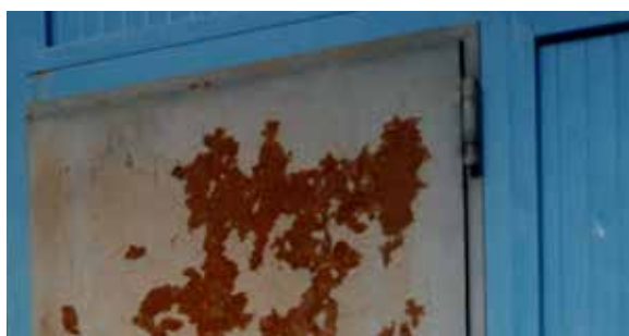
Fig. 5.2.3 Tartre, rouille instantanée, rouille blanche
