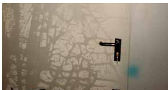
Fig. 5.3.1 Matériel de conditionnement inadéquat
